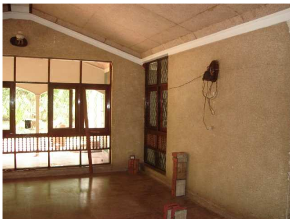
Der Eingangsbereich vor der Renovierung, ...
