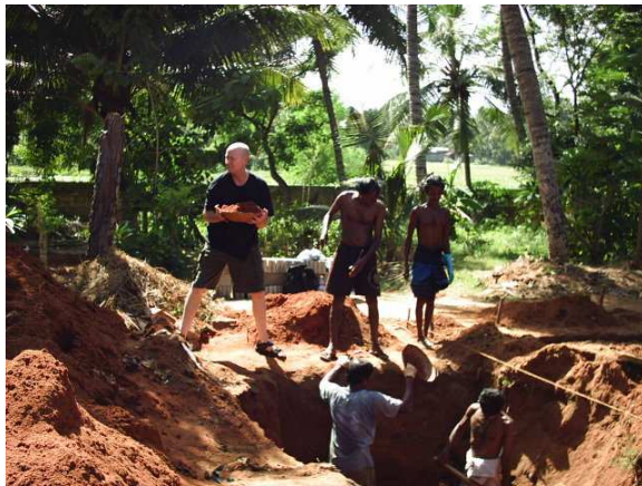
Linus mit einigen freiwilligen Helfern bei der Erstellung des Fundaments...
